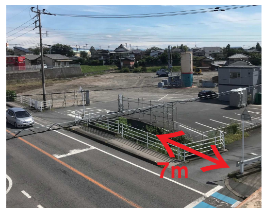
交通安全対策で道路拡幅(加藤田町入口)
