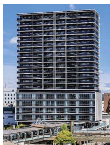
参考：民間再開発事業(愛知県刈谷市) 地上21階・店舗1・2階 公共施設3階・事務所4～7階
